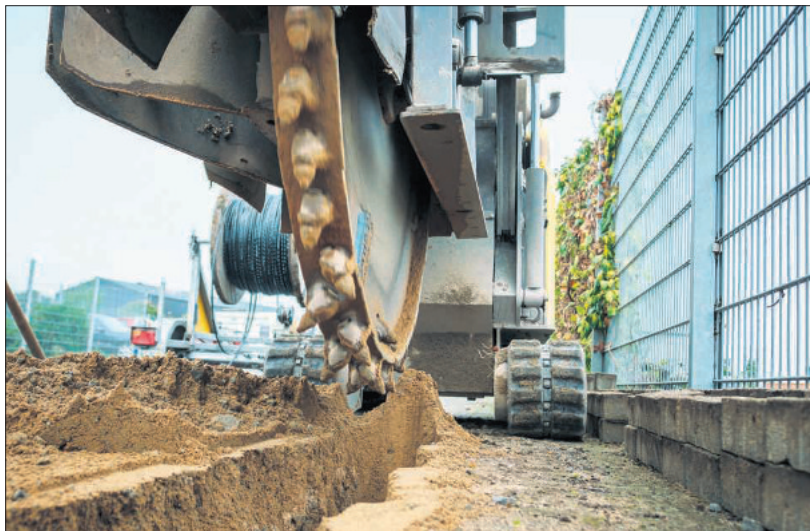
Mit der Methode des Trenching lassen sich Leitungen und Kabel schneller und kostengünstiger verlegen. [Bild zVg]
