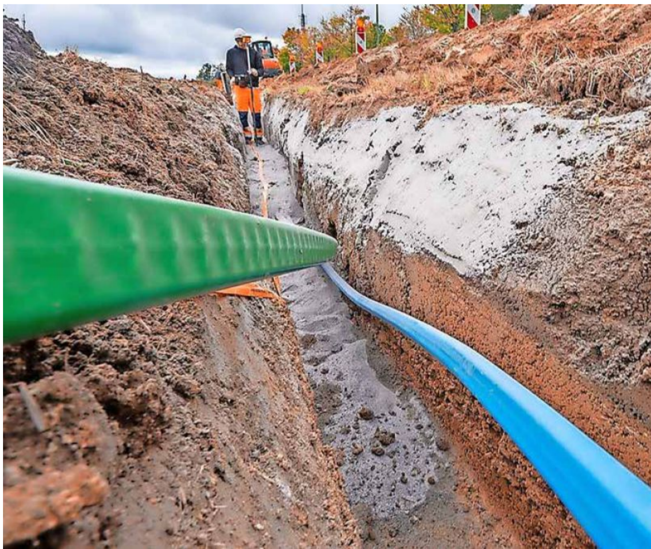
Das soll auch in abgelegenen Gegenden des Luzerner Westens geschehen: Glasfaserkabel werden verlegt. Foto Keystone
